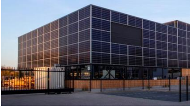
Howden in Hengelo (690 zonnepanelen)
