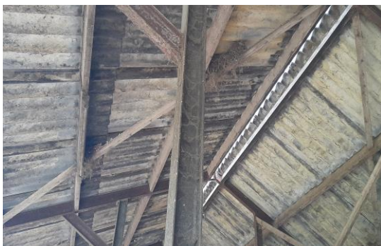
Foto 15. Open koeienschuur (4). Dak.
