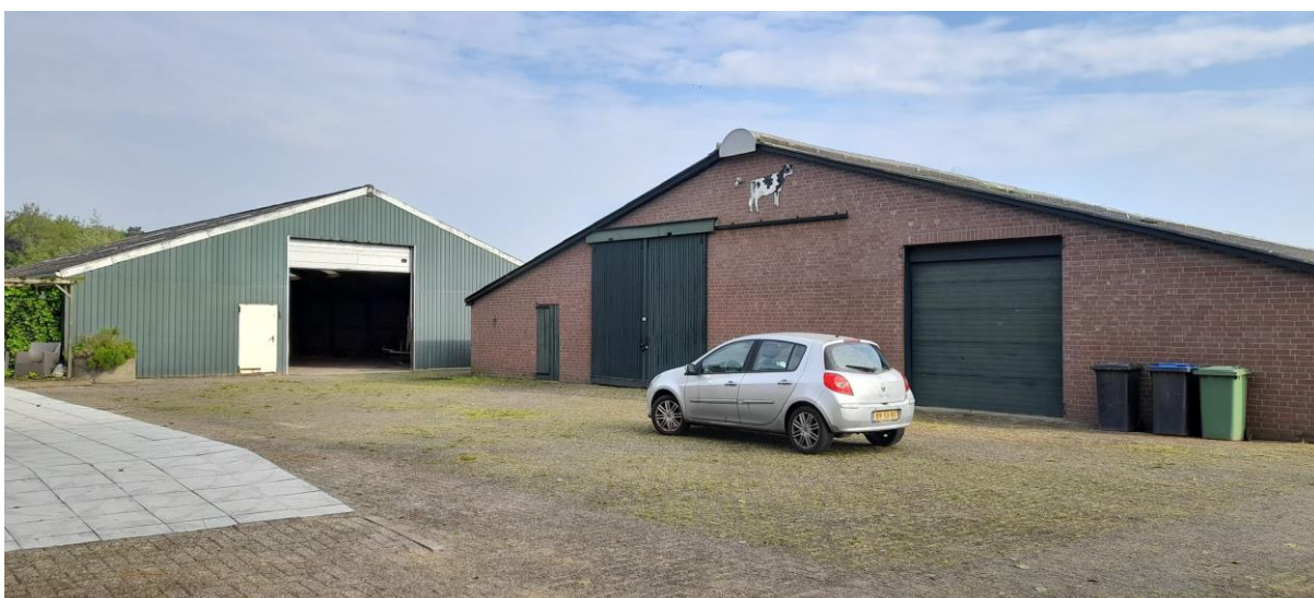
Binnenplaats met de twee te slopen schuren
