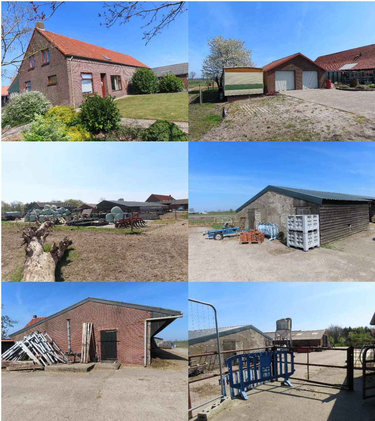
Figuur 3: Bestaande te slopen bebouwing. Bron: BNL advies
