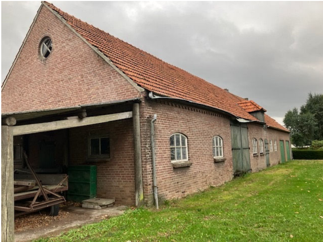
• Afbeelding 35: Te slopen boerderij voorzijde
