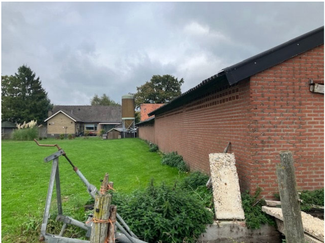
• Afbeelding 18: Zijkant met zicht op de bedrijfswoning
