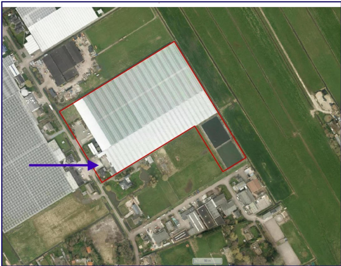
9: verticale luchtfoto 2018. Na brand in oktober 2017 is de opslagloods (aangegeven met blauwe pijl) naast de kassen ernstig beschadigd (zie H4 voor verdere toelichting).
