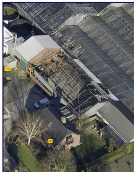
10: schuine luchtfoto 2018, ingezoomd op de beschadigde opslagloods
