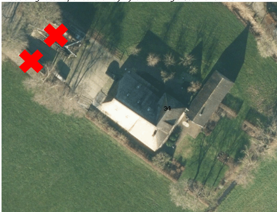
Afbeelding 5: te slopen schuren bij Linderteseweg 34 Raalte
