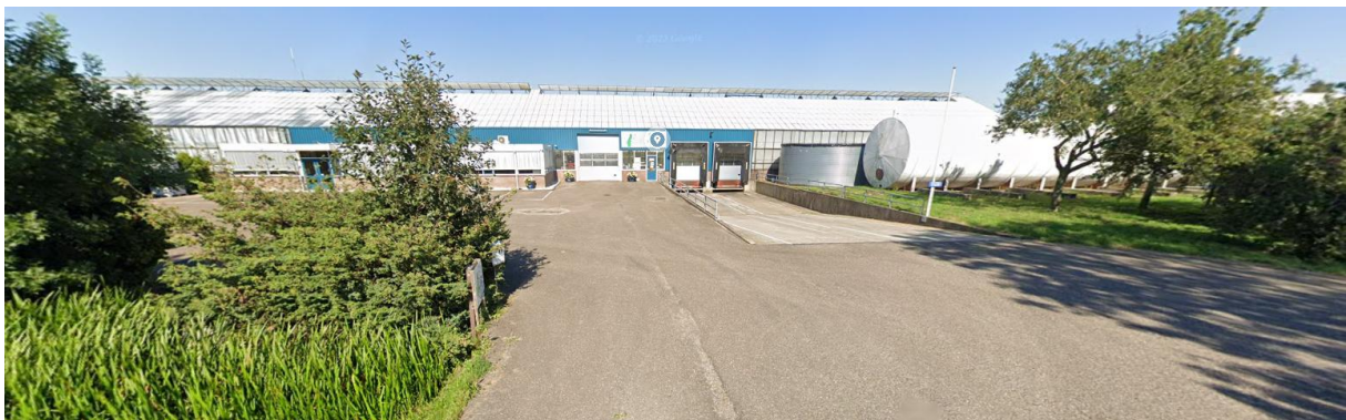
Aanzicht zuidwestzijde (bron: Google Streetview)
