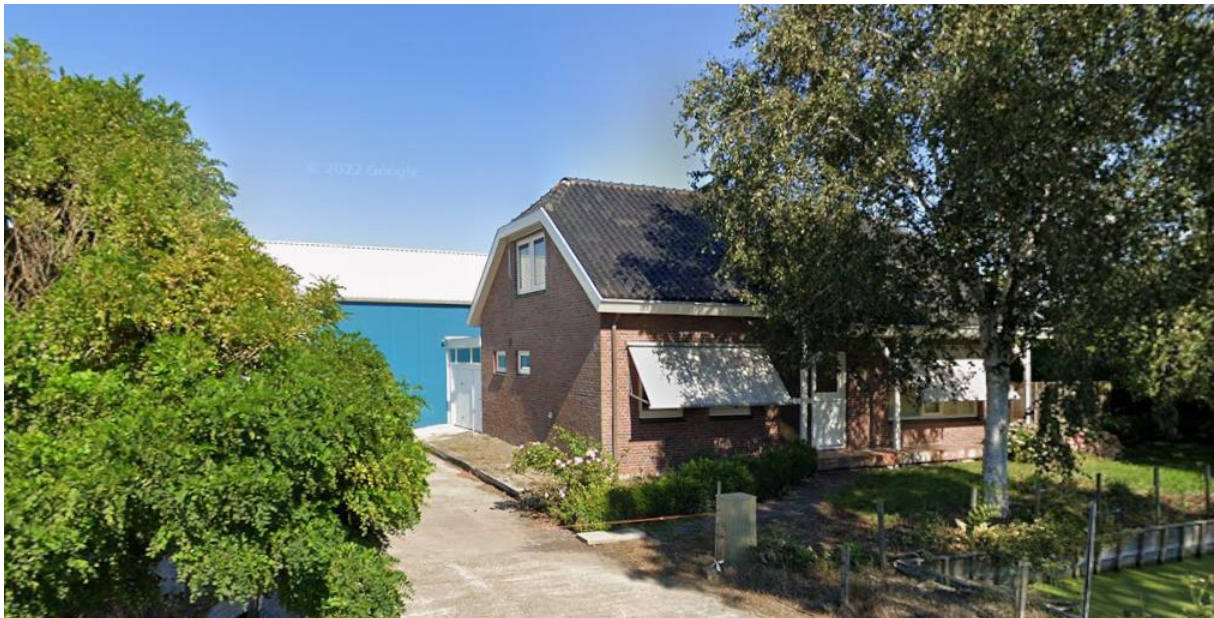
Aanzicht bedrijfswoning Huyssitterweg 19 (bron: Google Streetview)
