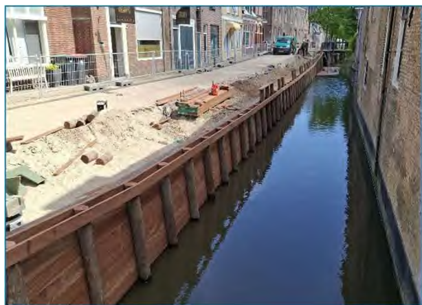
Nieuwe kade (staal + hout) Broerestraat Bolsward.
