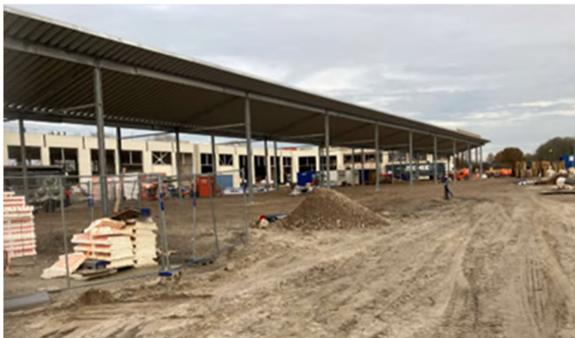
Foto: nieuwbouw buitendienst Bolsward.
