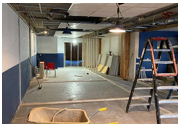
Foto: Verbouwing opvanglocatie Eeltjebaasweg Sneek
