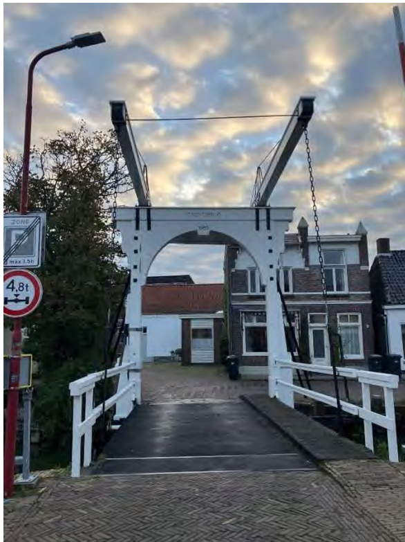
Herstelde Verzetsbrug in Makkum.
