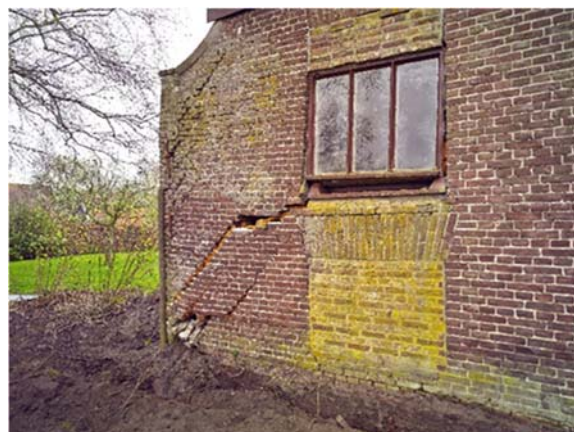
Funderingswerk Friese Boerderij
