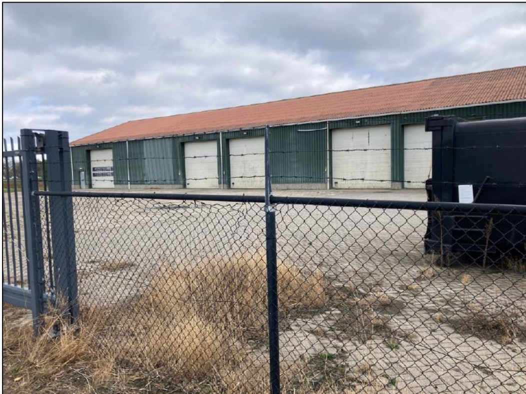
Foto 2.4 Zicht vanaf de Straalweg op de agrarische loods. De loods is niet onderzocht.
