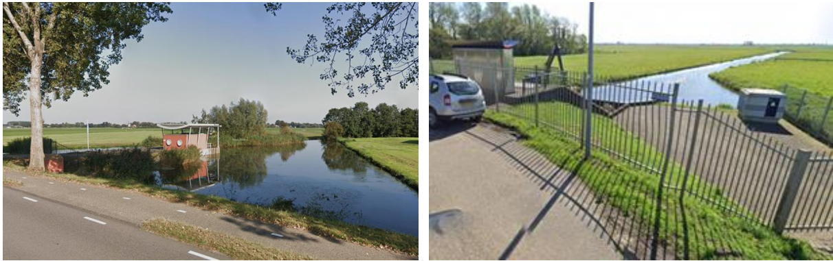
Figuur 2 Voorbeelden van assets die gevoelig kunnen zijn voor hoogwater in de polder (links: Gemaal vd Hoeker en Garstempolder ligt op polderniveau en is mogelijk gevoelig voor hoogwater in de polder. rechts: Gemaal Honswijk lijkt redelijk hoog, maar elektriciteitskast wel lager, mogelijk gevoelig voor hoogwater in de polder).
