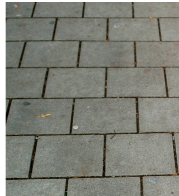
Trottoirs- 30x30 Afgestrooide betontegel
