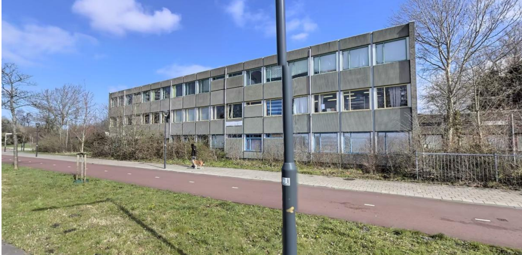
f 4.7 Het verouderde pand van de voormalige Grafische School op de beoogde bouwlocatie.
