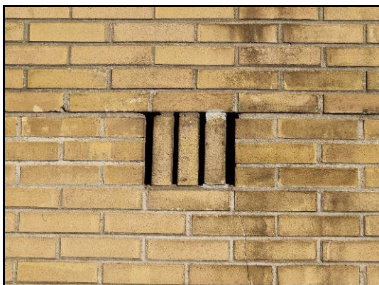
Afbeelding 5: Ventilatievoegen
