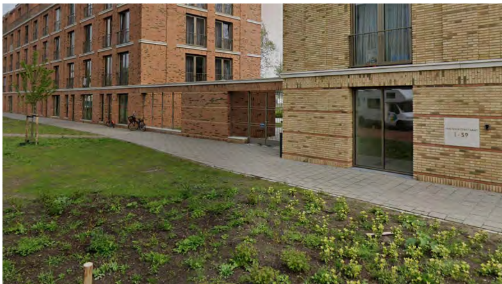
Referentievoorbeld: De trafo is geïntegreerd in een tuinmuur tussen de gebouwen. Project: Boerhaavelaan, Leiden, Geurst & Schulze architecten
