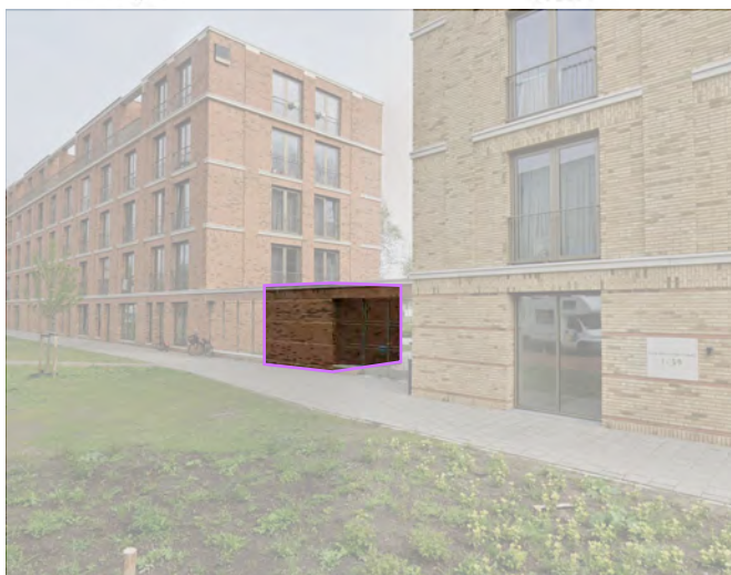
Referentiebeeld van een transformatorstation tussen gebouwen, architectonisch geïntegreerd in een tuinmuur (project Boerhaave, Geurst & Schulze Architecten).
