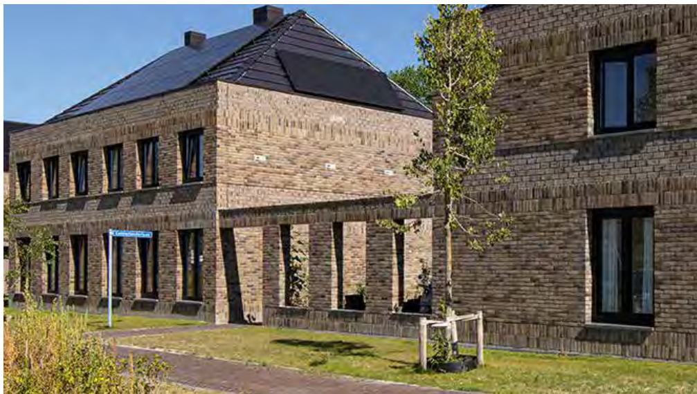
Referentievoorbeld tuinmuur tussen gebouwen Project: Poortgebouw Noord, Landgoed Wickevoort, Haarlemmermeer, M3H architecten
