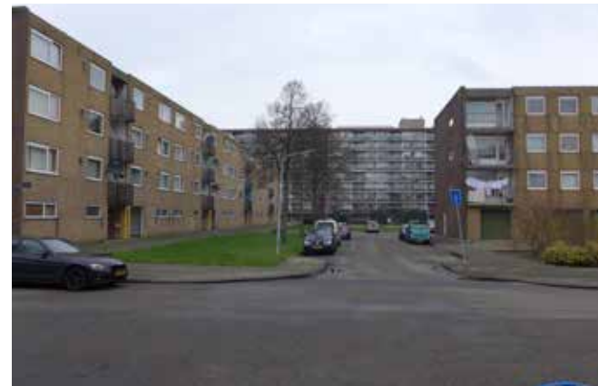
Op de voorgrond de bestaande te slopen portiekflats, op achtergrond te behouden galerijflat
