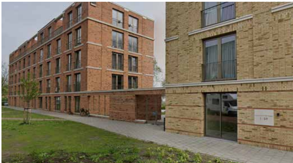
Trafo geïntegreerd in laag verbindende element tussen twee gebouwen. (Geurst & Schulze, Boerhaavelaan Leiden)
