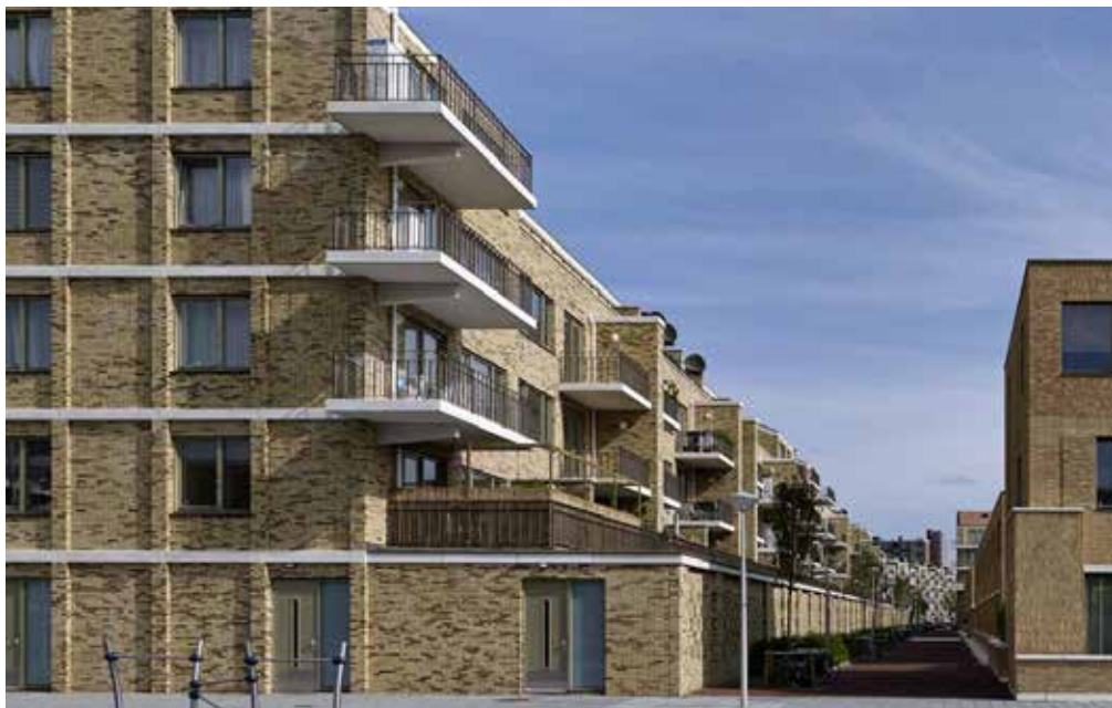
Een gebouwde parkeeroplossing, waarbij de parkeerplaatsen zijn overbouwd met woningen en terrassen en aan de zijde van de openbare ruimte met een muur worden afgeschermd. (Geurts & Schulze, Overtoomse Veld Amsterdam)
