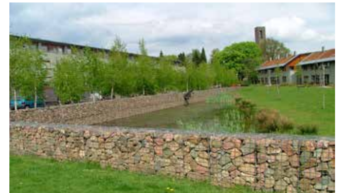
Een vijver kan bijdragen aan de verblijfswaarde, naast de betekenis voor waterberging. (Monnikenhuizen Arnhem, bureau Lubbers)
