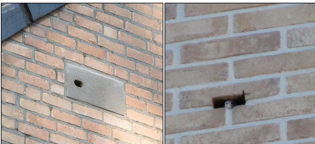
Figuur 4: Inmetzelstenen zichtbaar (links) en onzichtbaar (rechts) in de gevel verwerkt (bron: Vivarapro).
