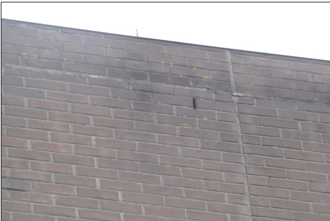
Figuur 9: Drie complexen hebben open stootvoegen aan de bovenkant van de korte zijde. Hier kunnen vleermuizen door naar de spouwmuur kruipen om daar een verblijfplaats te hebben. De daklijst sluit goed aan op de gevel.
