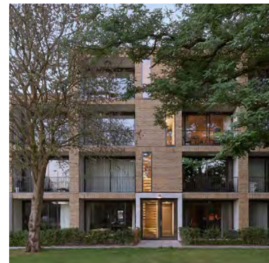
Referentiebeeld van een herkenbare centrale entree, subtiel aangelicht en zorgvuldig geïntegreerd in het gevelontwerp. Project: Hogenkampsweg, Zwolle, BDG architecten
