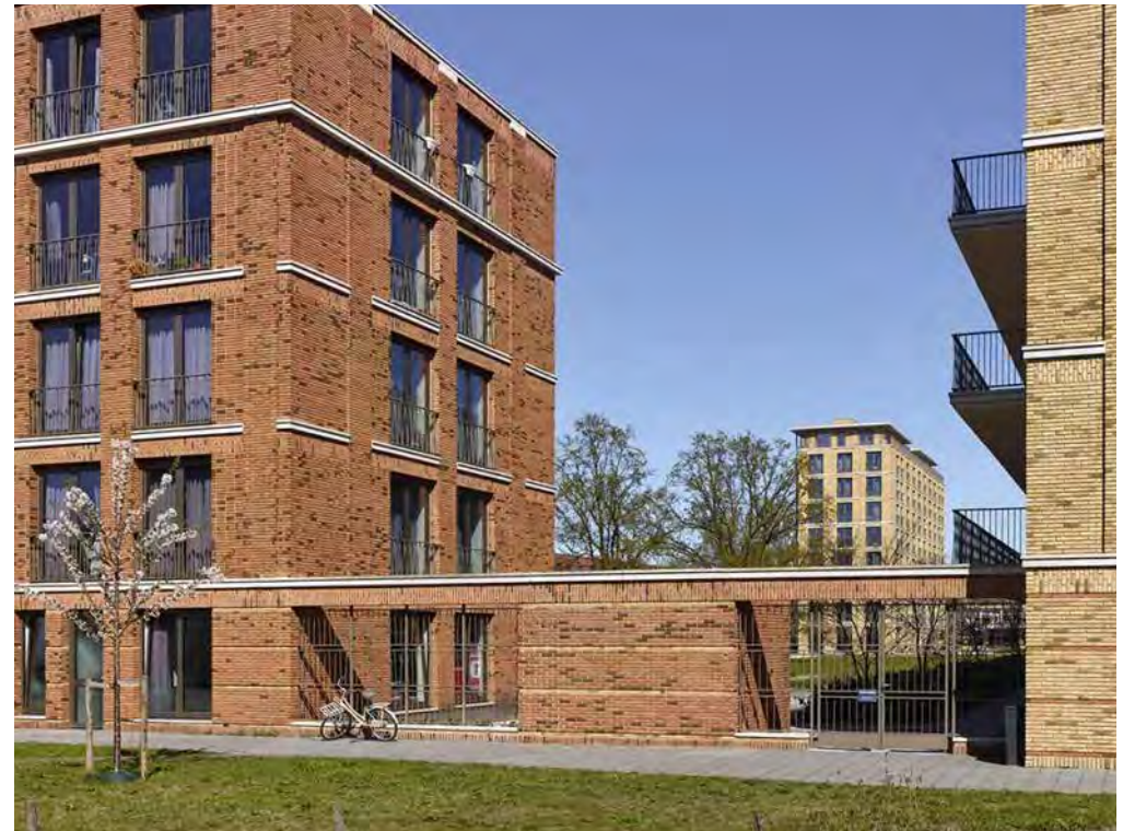
Referentievoorbeld waarbij een trafostation is geïntegreerd in een tuinmuur, uitgevoerd in hetzelfde metselwerk en met dezelfde detaillering, zodat muur en trafo als één geheel worden gelezen. Boerhaavelaan, Leiden, Geurst & Schulze architecten
