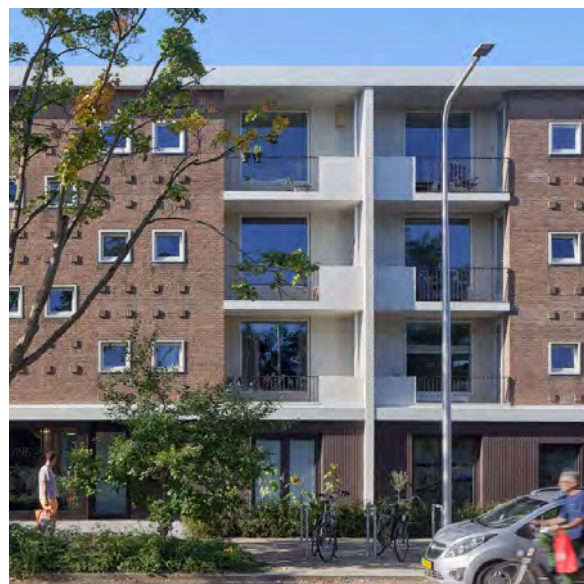
Combinatie van betonnen borstwering en open stalen hekwerk. Woningen Middelweg, Zwolle, BDG Architecten.
