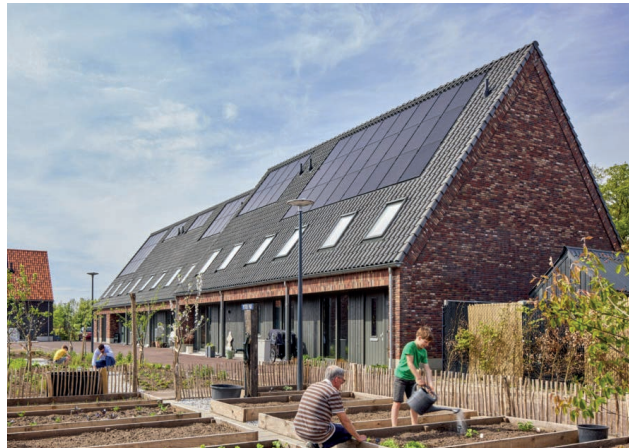
Metselwerk in gedekte aardeteint
