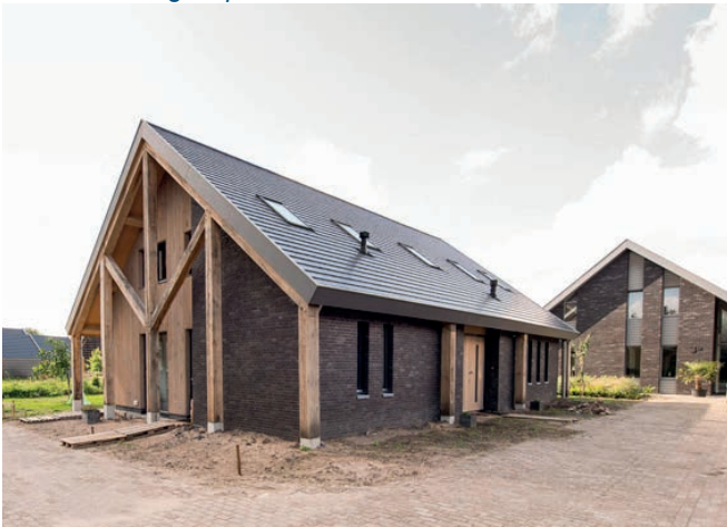
Eenduidige kap, heldere en eenvoudige hoofdvorm
