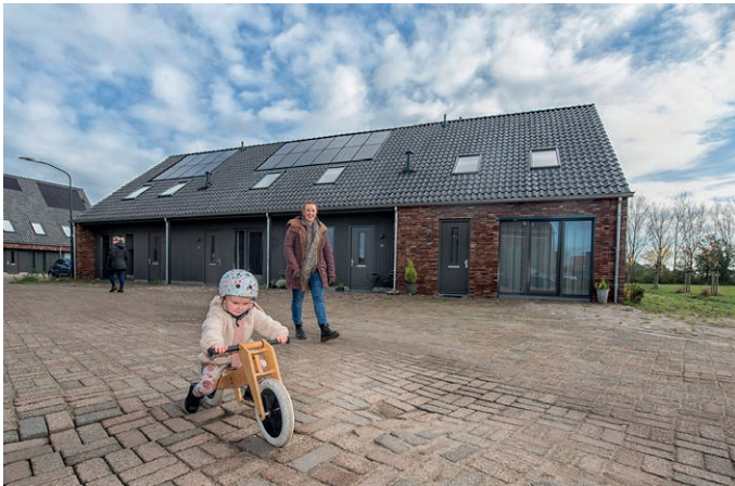
Eigentijdse uitwerking landelijke architectuurstijl
