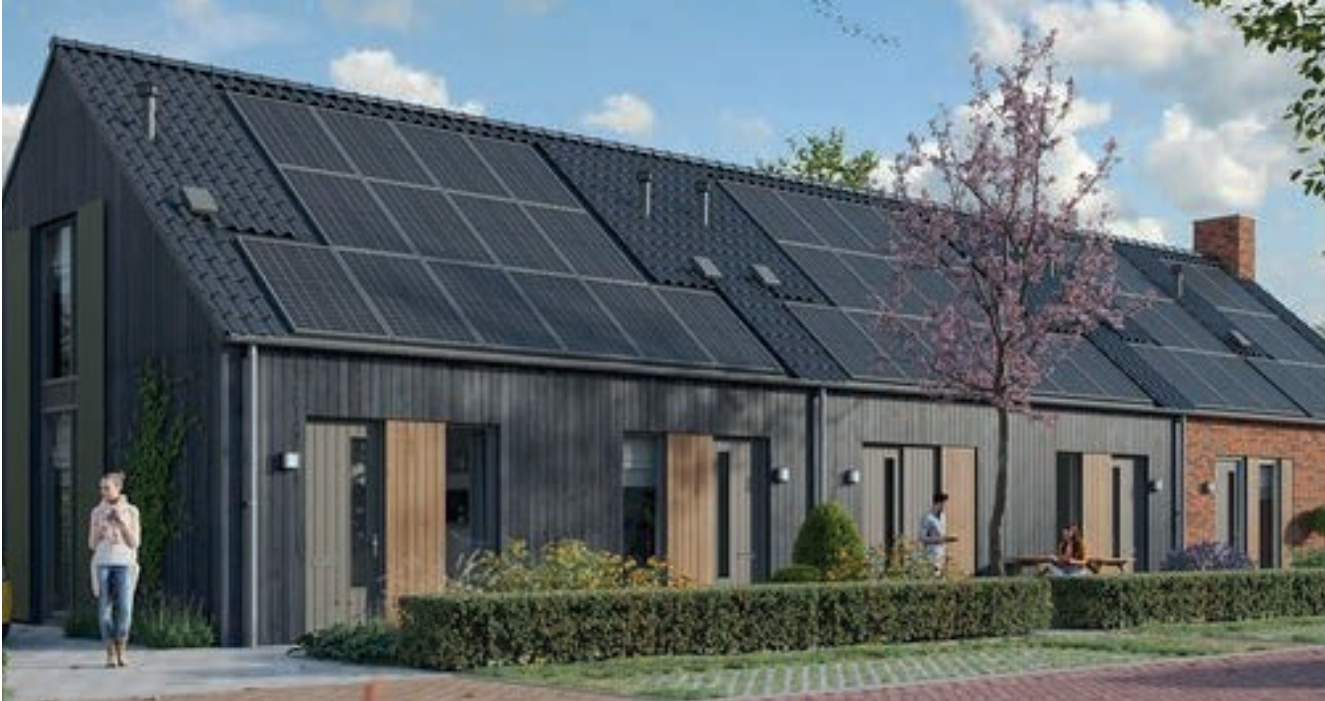
Metselwerk in aardetinten en hout in natuurlijke kleur en/of zwart
