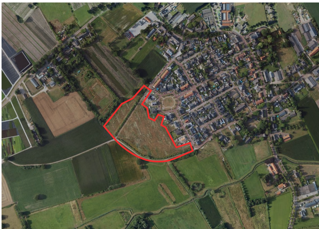
Luchtfoto plangebied en omgeving (bron: Cyclomedia)
