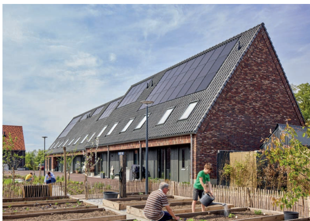
Metselwerk in gedekte aardeteint
