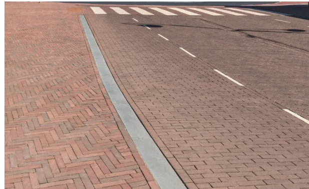
Rijbaan in gebakken materiaal
