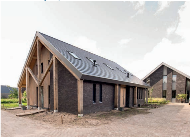
Eenduidige kap, heldere en eenvoudige hoofdvorm
