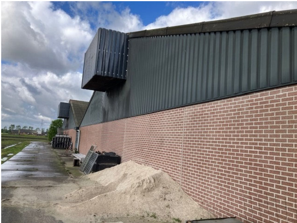
• Afbeelding 16: Achterzijde te slopen stallen
