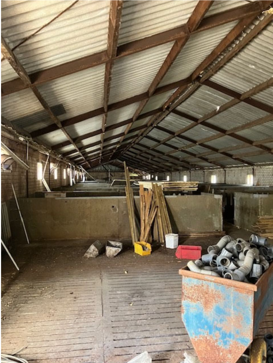
• Afbeelding 13: Binnenzijde te slopen varkensstal, ongeïsoleerd dak
