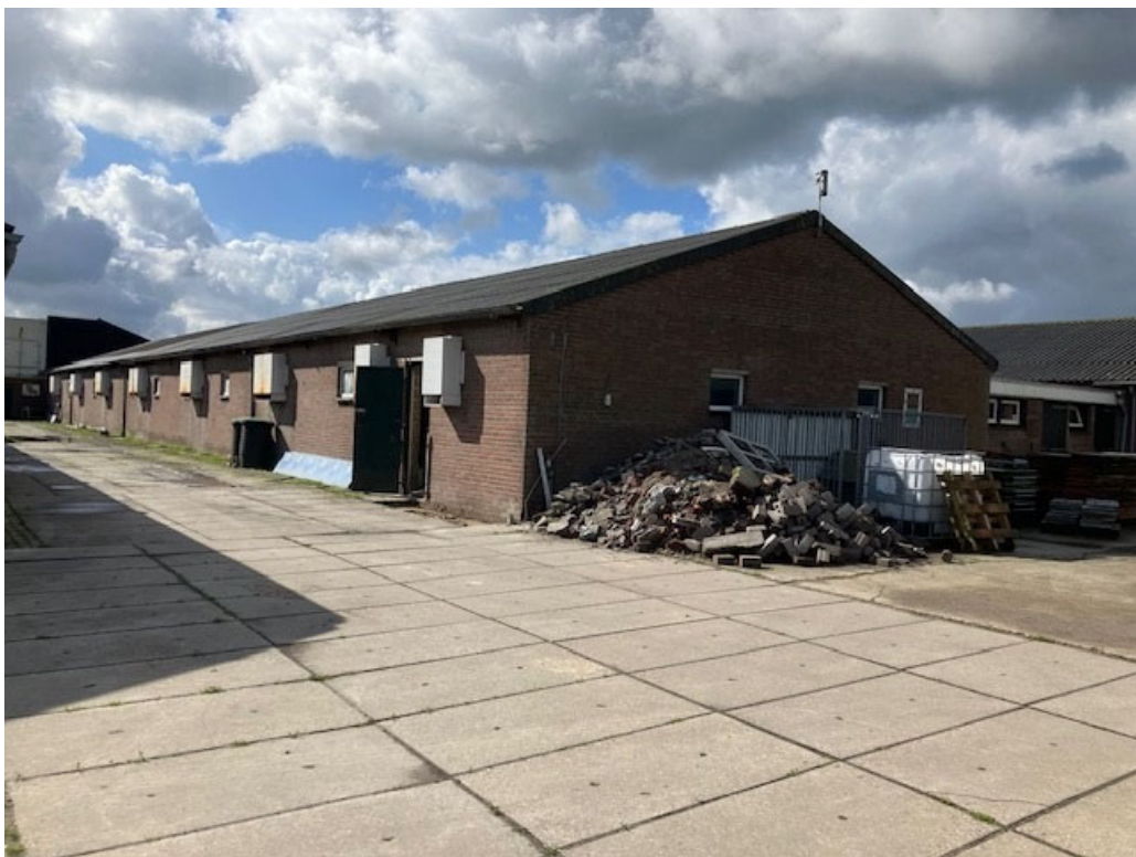
• Afbeelding 6: voorzijde te slopen stal met erf
