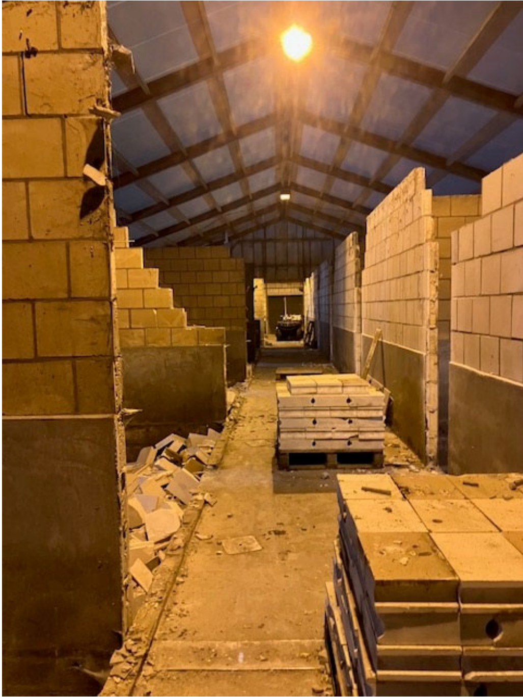
• Afbeelding 11: binnenzijde te slopen varkensstal
