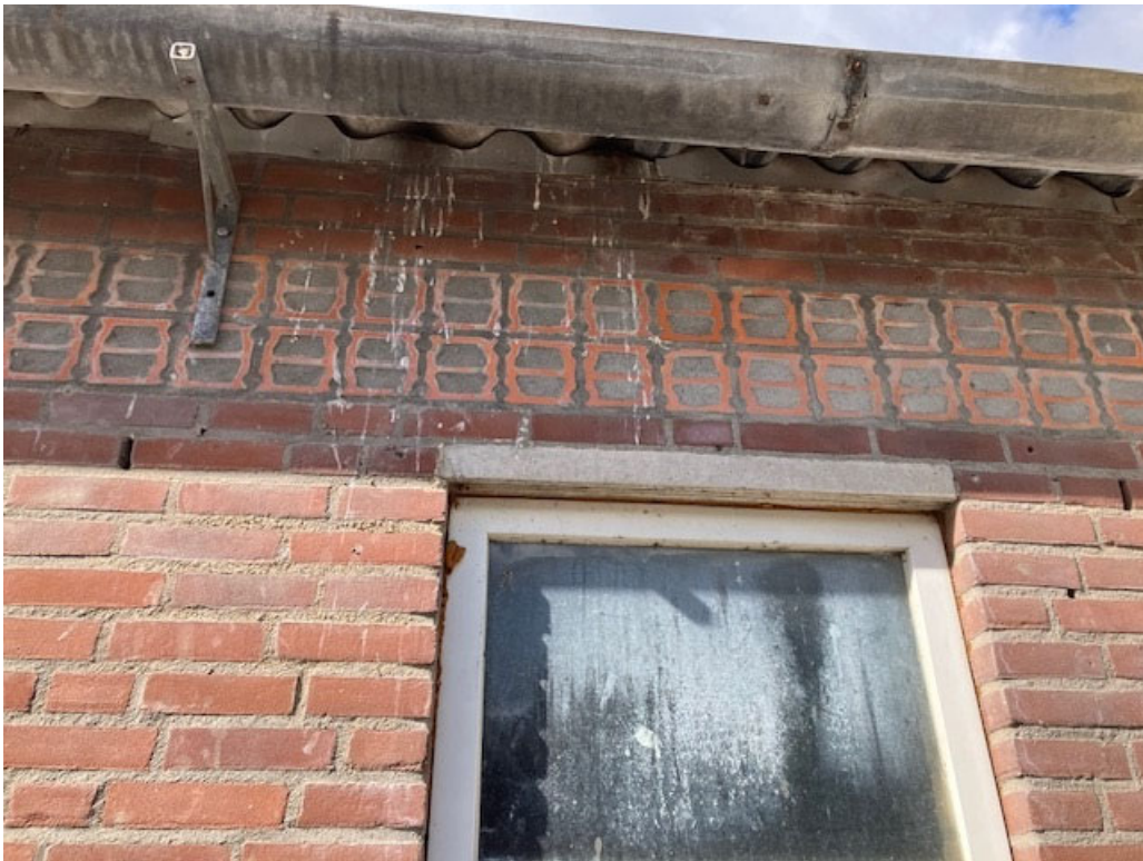
• Afbeelding 8: onderzijde dakaansluiting, plekken waar spreuwen hebben gebroed, nu niet gezien
