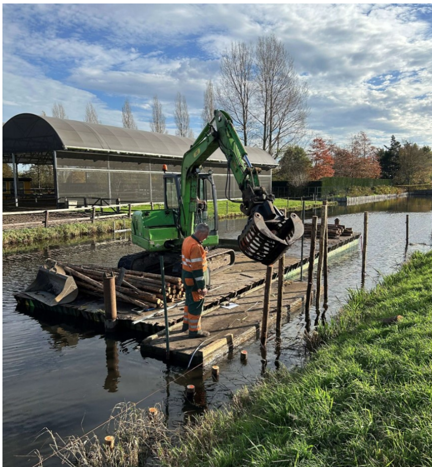
Project Amstelveen: Aanleg natuurvriendelijke oever levert kennis op voor de aanleg op een slappe bodem met afkalvende oever.
