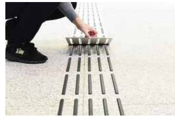
Kleur van de markering wordt afgestemd met TG Lining. Deze moet voldoende contrast hebben met de steen i.v.m. zichtbaarheid
