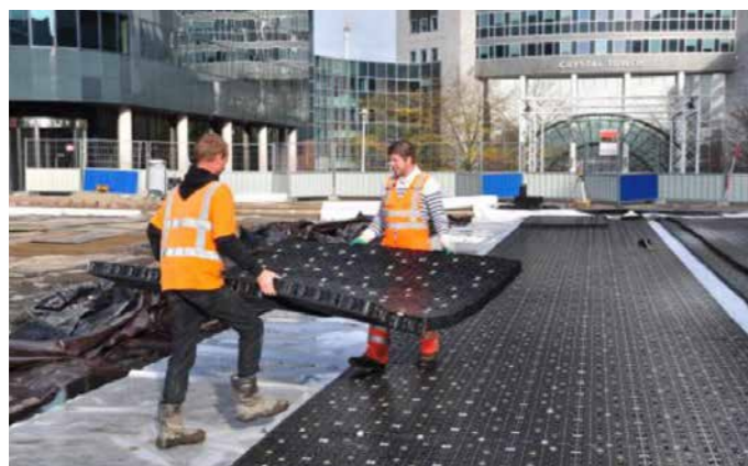
Referentiebeeld aanleg retentiekragen systeem onder Orlyplein Amsterdam
