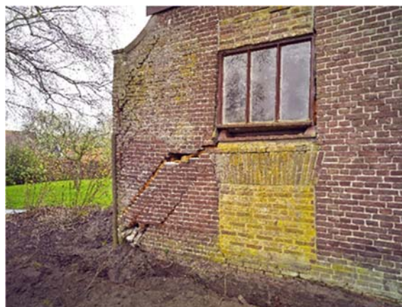
Funderingswerk Friese Boerderij
