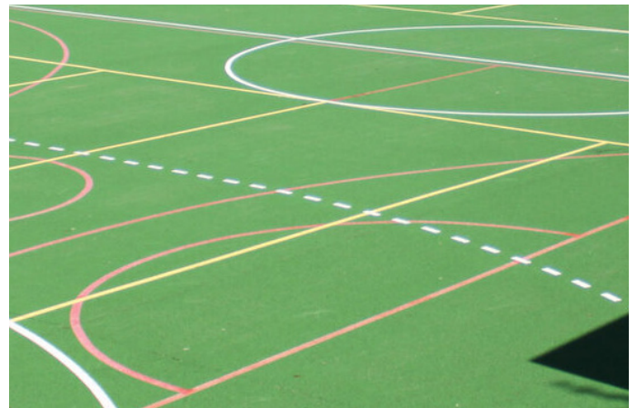
Voorbeeld van drainbeton (verkrijgbaar in meerdere kleuren) als ondergrond voor de sportkooi.
