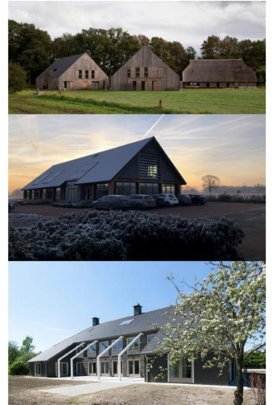
Woningbouw op het erf.
