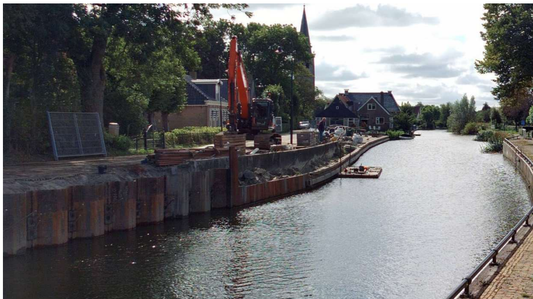
Werkzaamheden aan de kade langs de Doniaweg in Burgwerd, september 2024.
