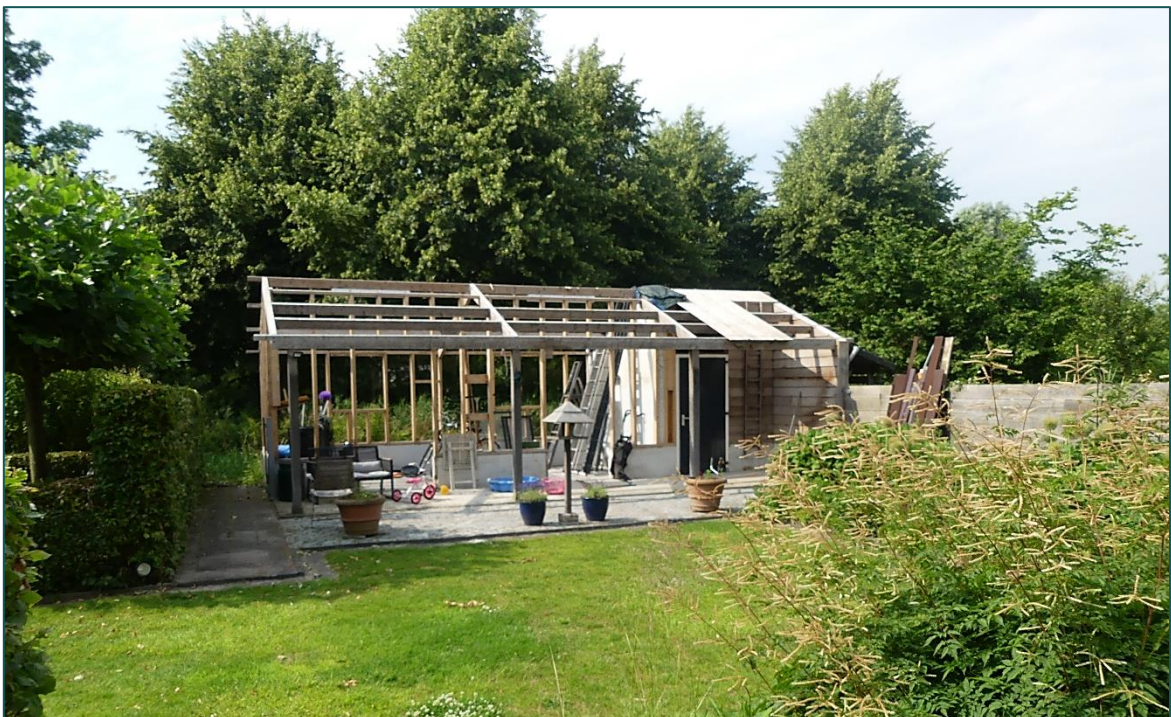
Figuur 2 De te slopen bebouwing bestaat uit een bijgebouw welke is opgetrokken uit houten balken.
