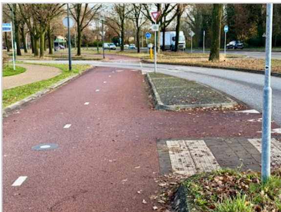
Enkelbaans oversteek busbaan bij Het Pluuke. Hier zijn geen waarschuwendes witte puntstukken aangebracht.
