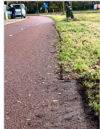
Voor de foto deels verwijderde, 20 cm brede, overgroeiing langs de Europalaan achter het Nuenens College. Ballpoint voor schaal. Het gras ligt op dezelfde hoogte als het fietspad, vergevingsgezind als men even van het pad af raakt.
